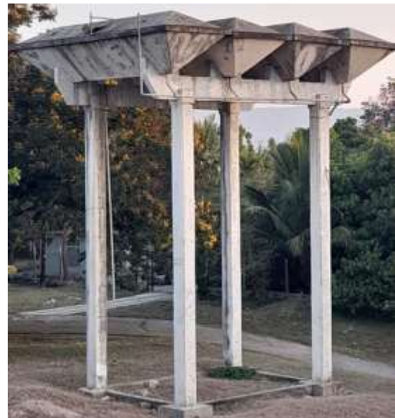
Figura 1. Tanque prefabricado utilizado en Cuba para la distribución centralizada de agua por gravedad.
